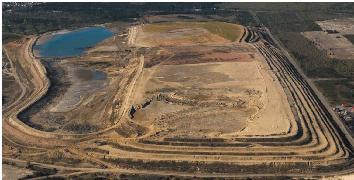
Stawy osadowe odpadów poflotacyjnych, Źródło: Biuletyn Informacyjny ZGH Bolesław nr 7/10
